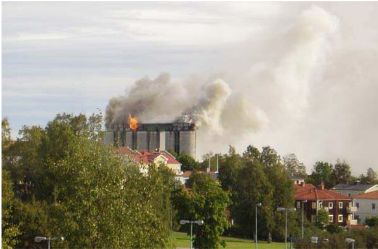
Bild 6 Brand i pelletsilo orsakad av självtändning (Foto: Räddningstjänsten).
