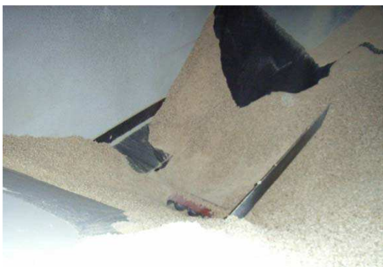
Bild 3 När pelletsen sinar i förrådet blir matningsskruven synlig. Risk för CO-exponering vid inträde. (Foto U. Svedberg)
