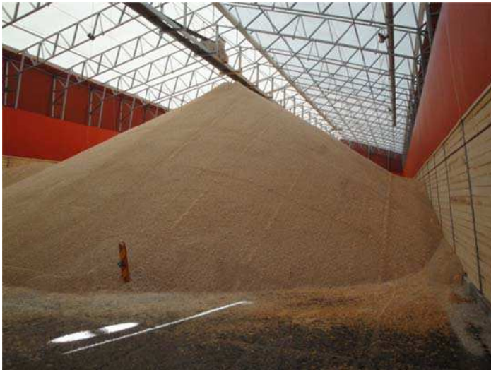
Bild 2 PVC-hall med träpellets.
